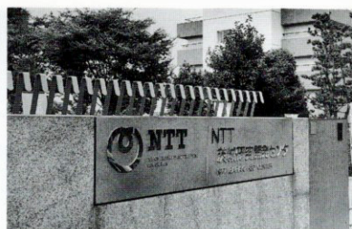
茨城県東海村にある NTT茨城研究開発センター
