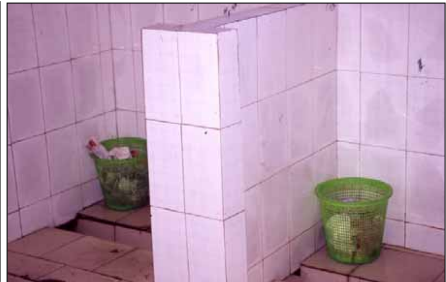
公園内の公衆トイレ。
